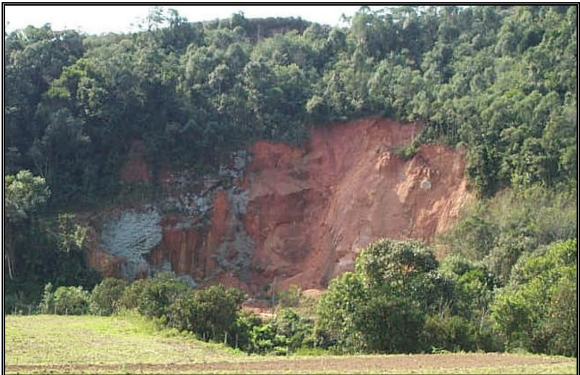
**Foto 3.3.24** - Instabilidade na encosta. Deslizamentos associados a exploração de saibro junto a base – Trecho São Bonifácio – São Martinho (próximo localidade de Santa Maria)
