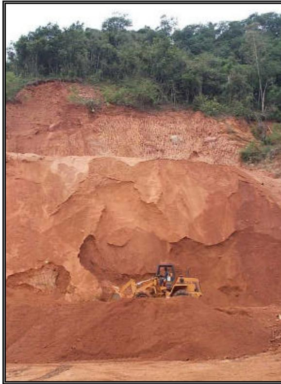
**Foto 3.3.19** - Saibreira em atividade. Situações típicas: desmatamento, corte íngreme e de grande altura sujeito a deslizamentos e muito material de rejeito sujeito a erosão – Trecho Orleans – Pedras Grandes
