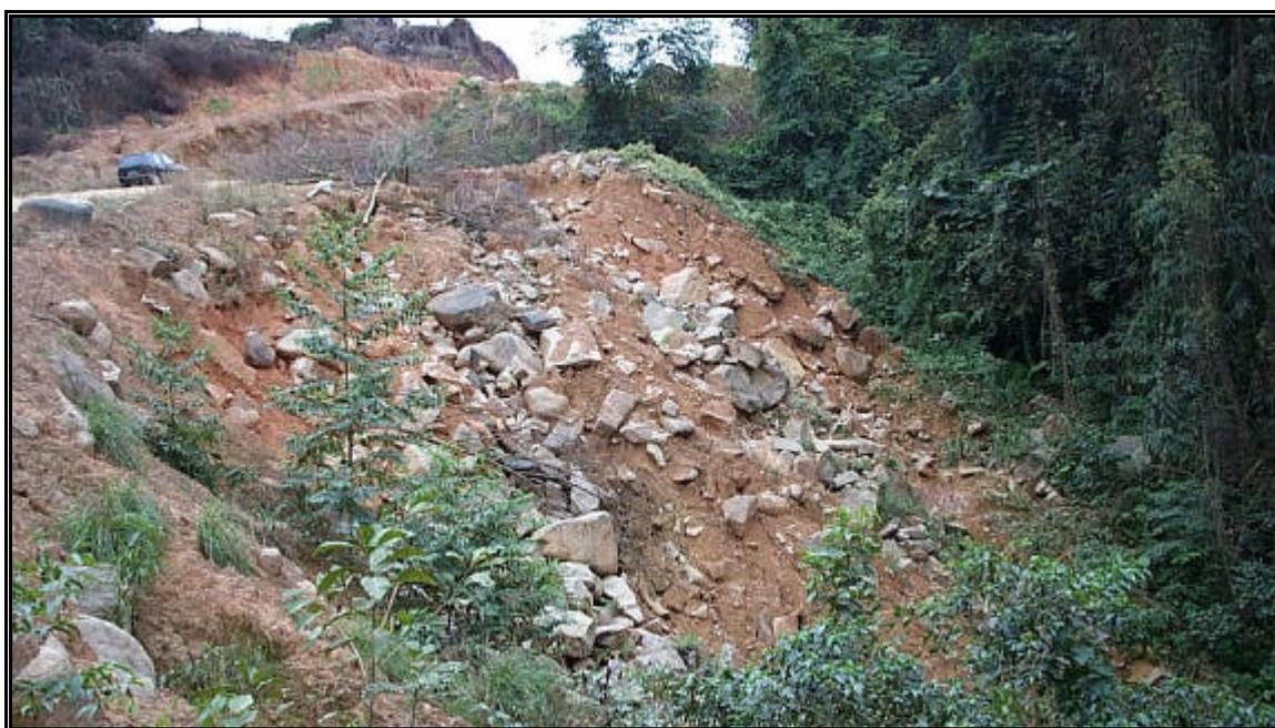
**Foto 3.3.27** - Material da estrada constituído por solo e blocos de rocha lançados sem critério em direção ao rio Bravo - Trecho Rio Fortuna – Santa Rosa de Lima (próximo do acesso a localidade de Rio Bravo Baixo)
