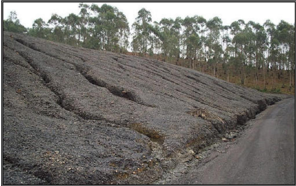
**Foto 3.3.13** - Ravinamento de pilha de resíduos de mineração – Lauro Müller
