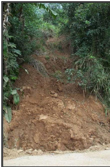
**Foto 3.3.30** - Processo de instabilidade da encosta por fluxo de detritos – Trecho Orleans – Pedras Grandes
