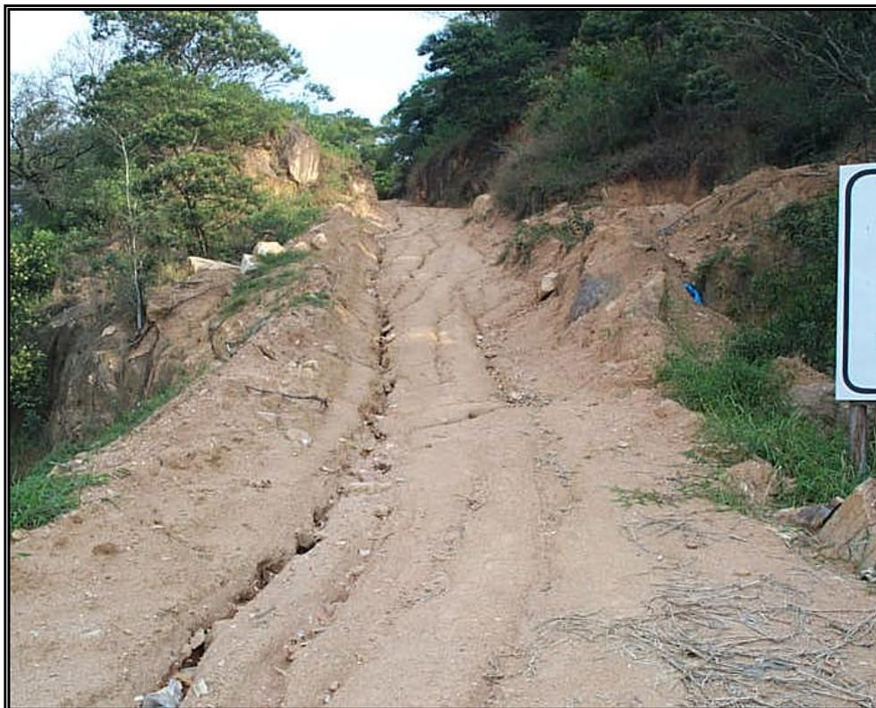
**Foto 3.3.32** - Processos erosivos por ravinas em estrada de acesso não pavimentada – Trecho Gravatal – Tubarão (localidade de São Martinho)
