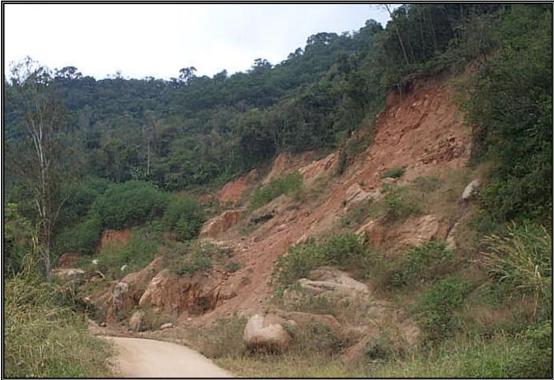
**Foto 3.3.25** - Encosta mostrando instabilidade devido a extração de material. Tal feição constitui situação de risco à estrada – Trecho Orleans – Pedras Grandes
